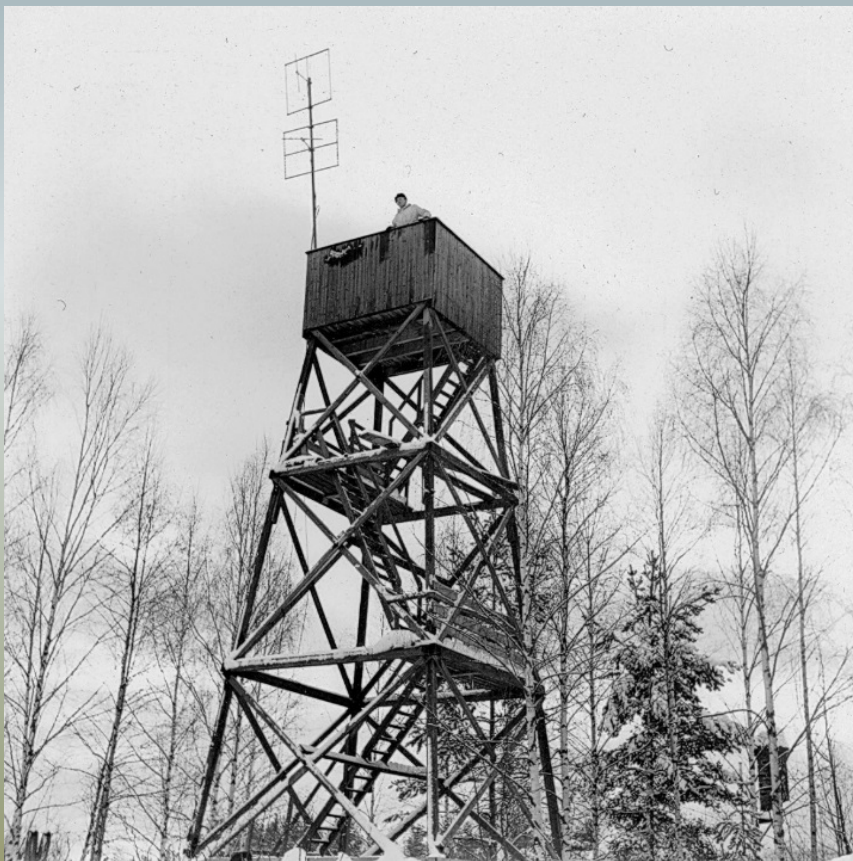
Äldre trä torn med antenner för RL-01
